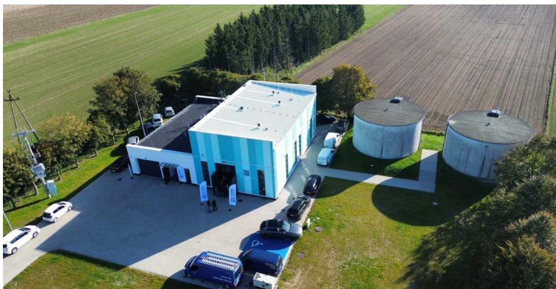
Zdjęcie 3. Nowa Stacja Uzdatniania Wody w Bukownicy
