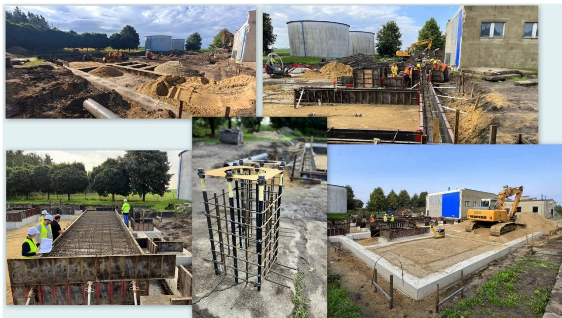
Zdjęcie 2. Stacja Uzdatniania Wody w Bukownicy – w trakcie realizacji inwestycji.
